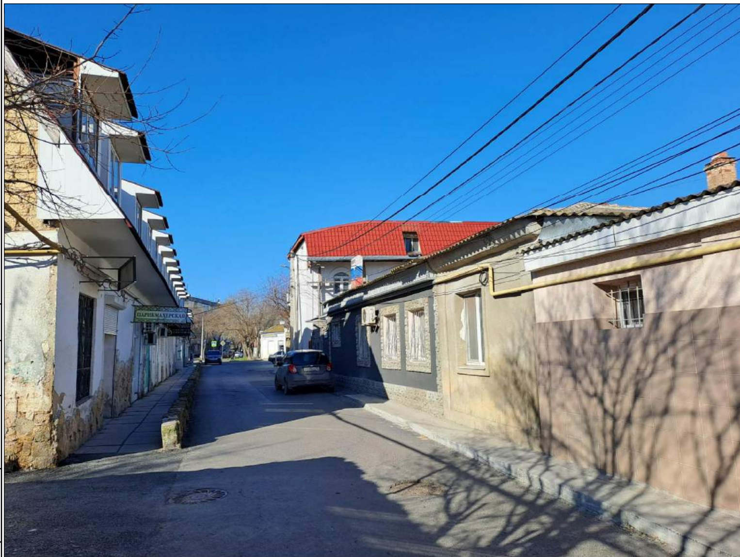
Фотофиксация существующего состояния внешнего вида жилого дома
