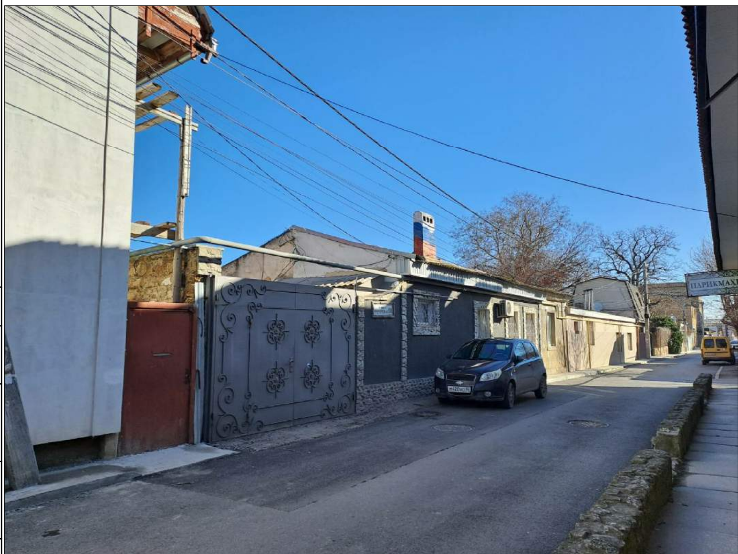
Фотофиксация существующего состояния внешнего вида жилого дома
