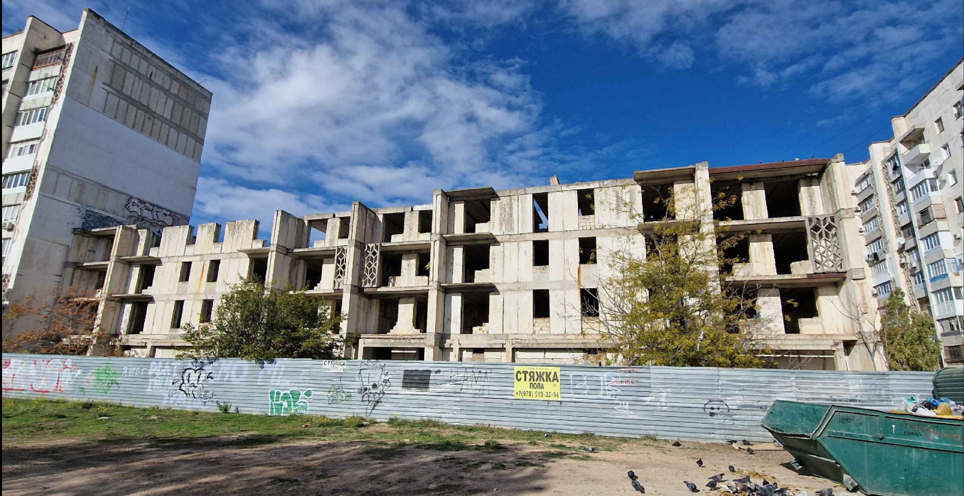
Фото 1. Фасад объекта незавершенного строительства со стороны улицы Интернациональная.
